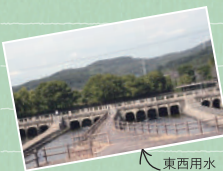
東西用水酒津樋門
