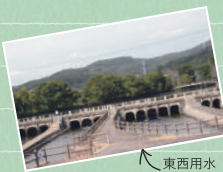
東西用水酒津樋門
